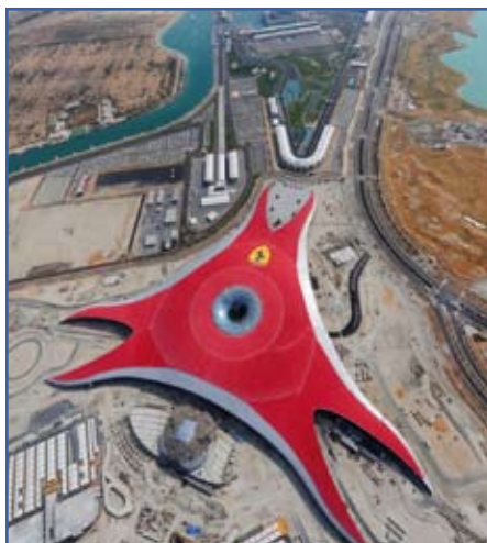
Dach von S+T Fassaden im Themenpark „Ferrari World Abu Dhabi“
